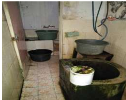
Gambar 4.7 Kondisi Sumur Warga
