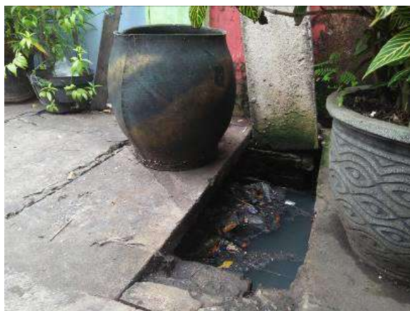
Gambar 4.11 Kondisi Sebagian Selokan di RW VI Kelurahan Rangkah Tahun 2018
