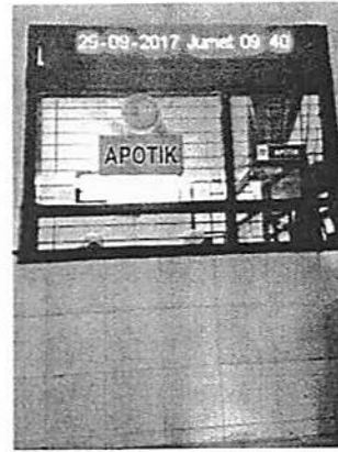
Gambar 5.44 tampak depan ruang pengambilan obat di Puskesmas Nganjuk
