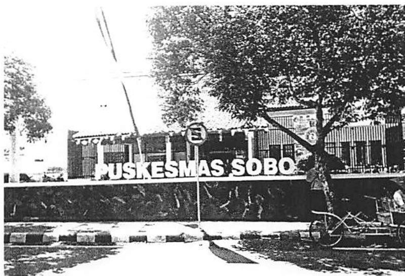
Gambar 5.3. Tampak Depan Puskesmas Sobo Sumber : Dokumen Penelitian
