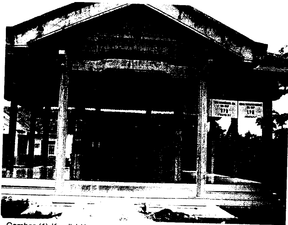
Gambar (1) Kondisi Kantor Pemerintahan Desa Gelap - Lamongan, Setelah Bencana Banjir
