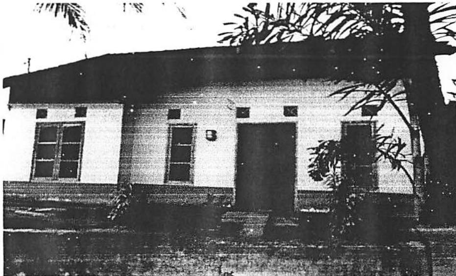
Gambar 5.3. Bekas Bangunan Gudang Pabrik Kopi
