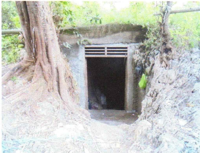
Gambar 4.7 Pintu masuk yang digunakan oleh penambang kotoran kelelawar
