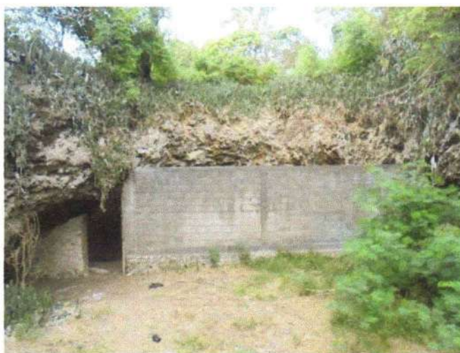
Gambar 4.2 Mulut Gua Pongangan 1 bertembok beton
