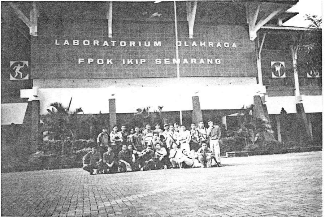
Gedung Laboratorium Olahraga FPOK IKIP Semarang
