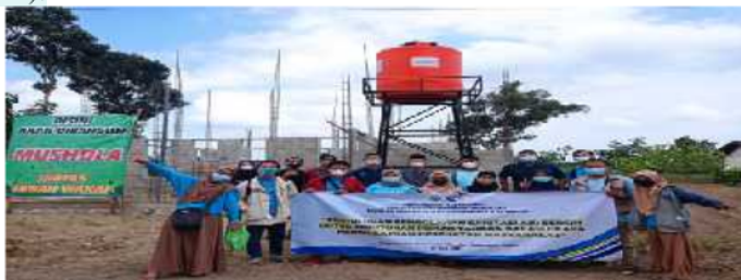
Gambar 1. Proses Penampungan Air Bersih dengan Pemasangan Tandon Air
