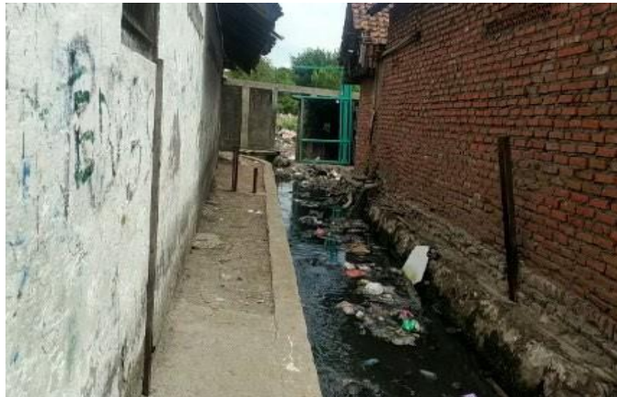
Gambar 3. Kondisi sampah yang terbawa dari aliran sungai di lingkungan RW XI
