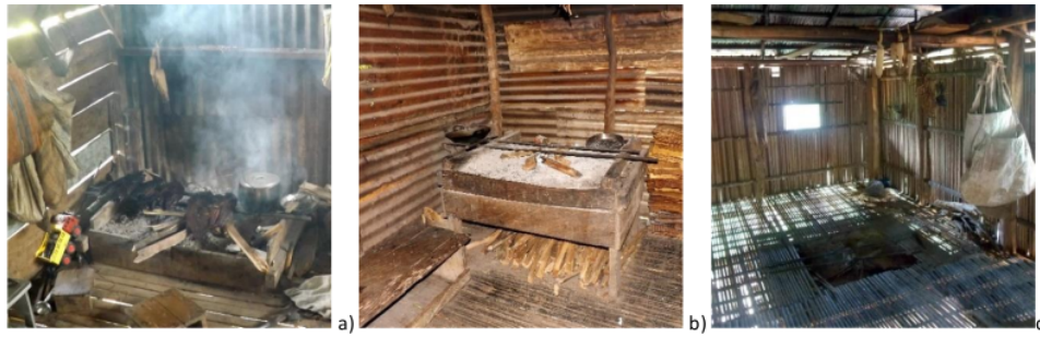
Gambar 2. Tungku Memasak Suku Muyu; a) Tungku Perempuan Model Duduk; b) Tungku Perempuan Model Berdiri; c) Tungku Laki-laki. Sumber: Dokumentasi Peneliti
