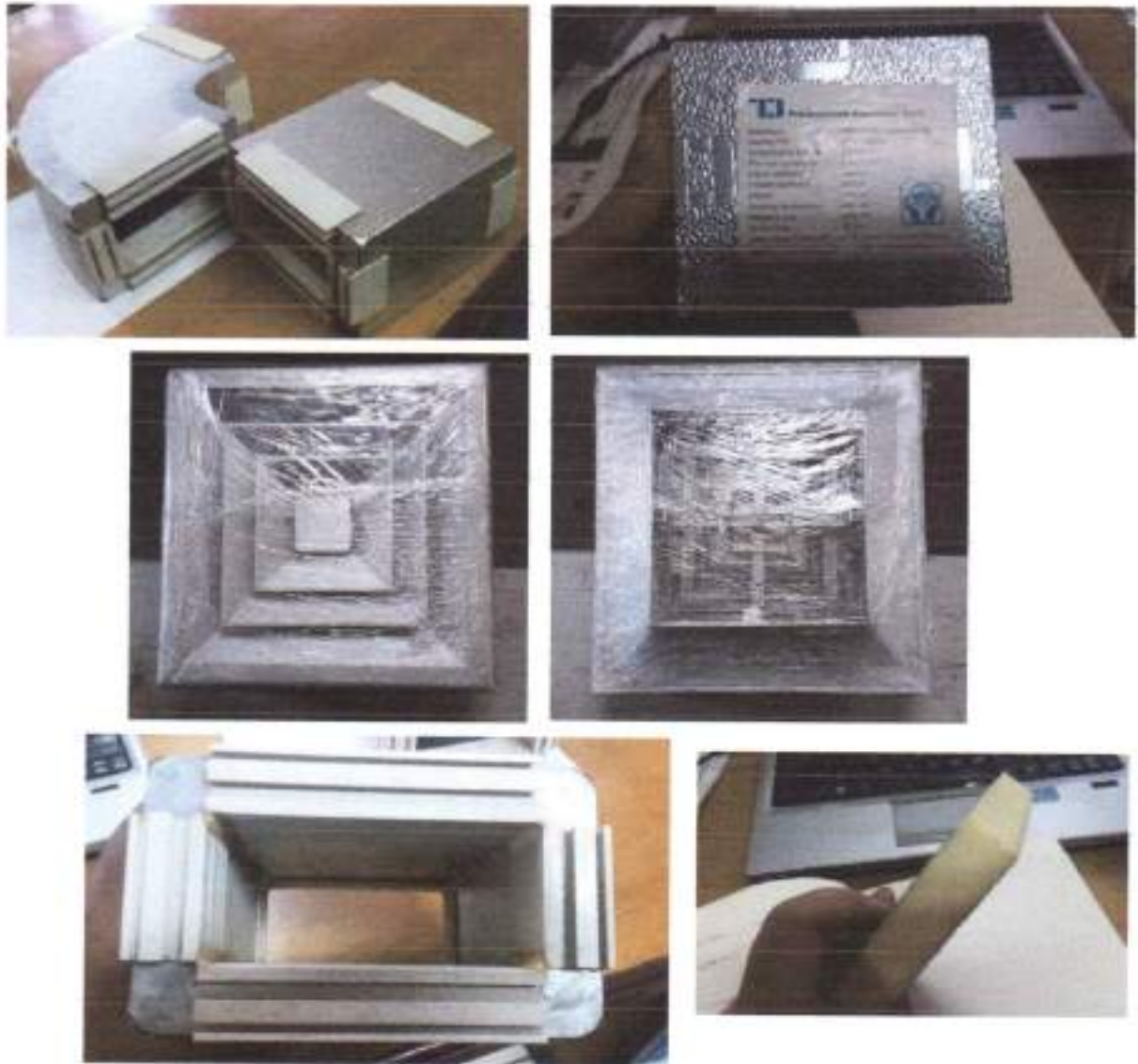
Gambar 5. Material yang dipakai untuk sistem ducting, polyurethane yang di bungkus dengan aluminium foil. Untuk sistem exhaust ada penyesuaian ukuran ducting/ saluran, karena ada harus dites agar sesuai target tekanan statis yang harus di jaga.
