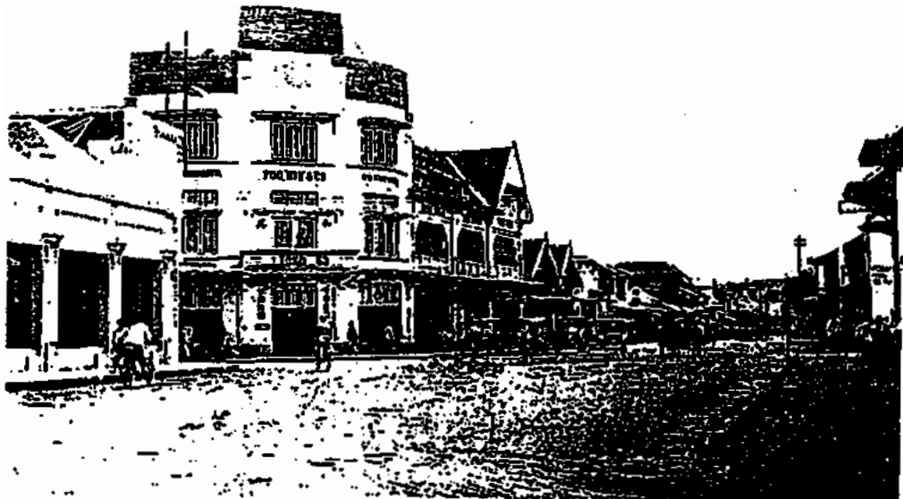
Foto 8 Sudut bangunan toko 69
