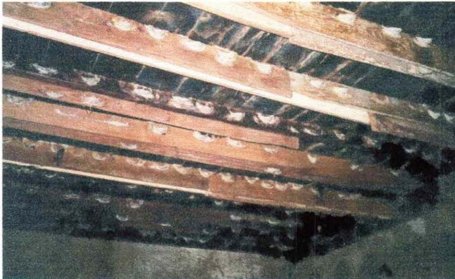
**Gambar 1.** Bentuk pemasangan papan sirip
