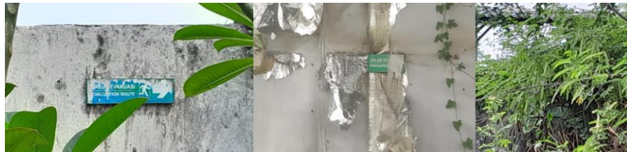
Gambar 4.5 Kondisi Jalur Evakuasi Gas Plant Minarak Brantas Gas, Inc.
