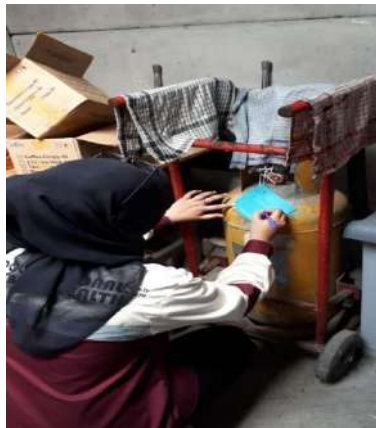
Gambar 4.6 Alat Pemadam Api Beroda (APAB)
