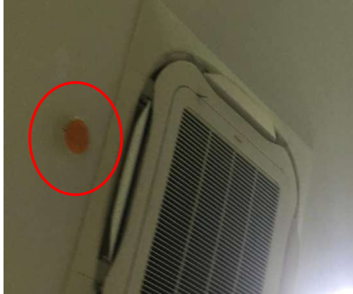
Gambar 4.9 Detektor Kebakaran di Rumah Sakit
