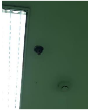
Gambar 4.14 Sprinkler dan Detektor Kebakaran
