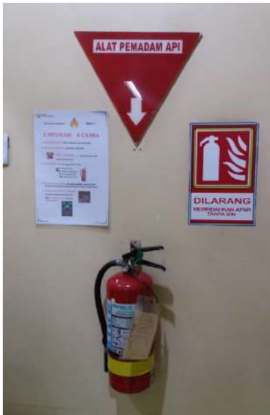
Gambar 4.5 Peletakan APAR
