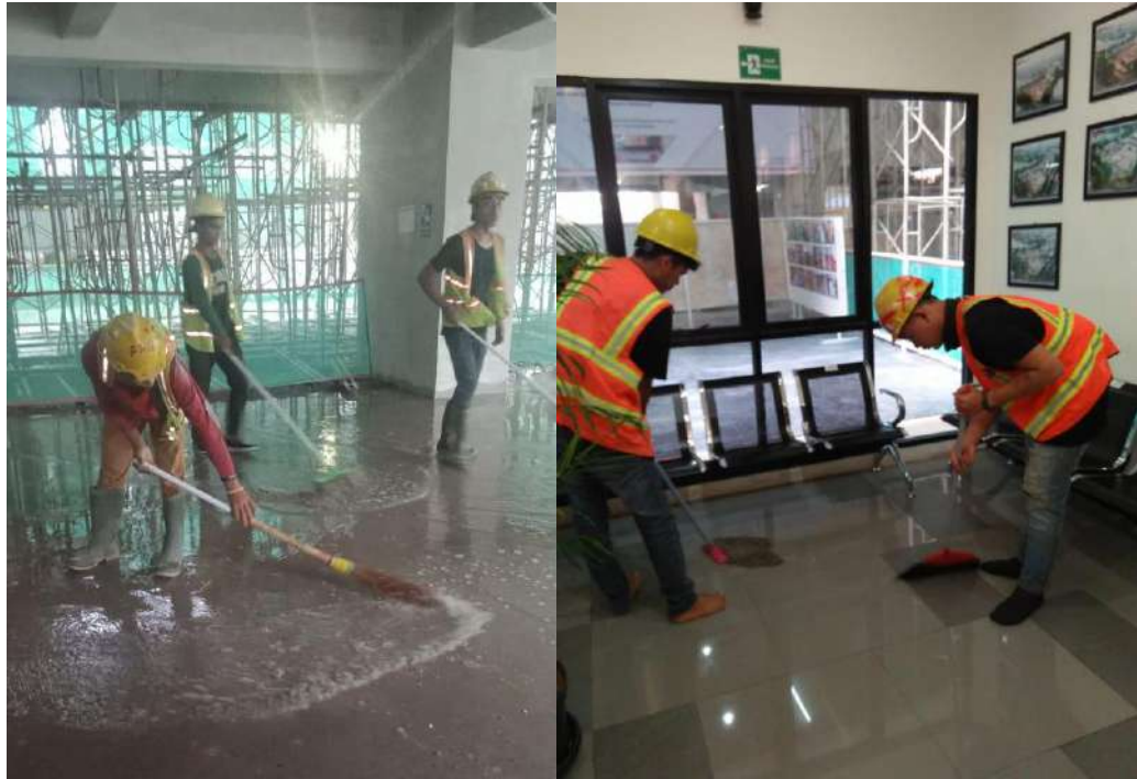
Gambar 4.14 Pembersihan wilayah proyek dan pembersihan area kantor
