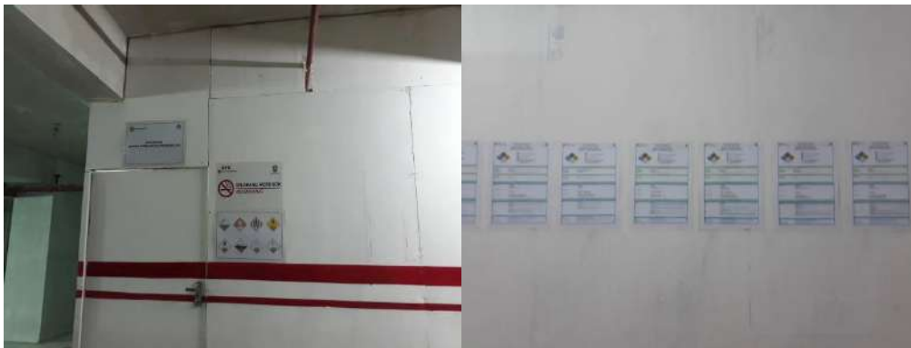
Pembuatan dan pemasangan lembar MSDS pada Gudang B3
