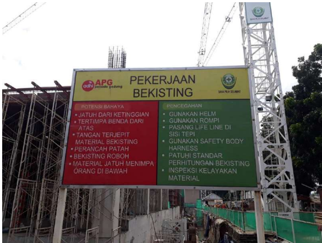
Gambar 4.9 Potensi bahaya dan pencegahan pekerjaan bekisting
