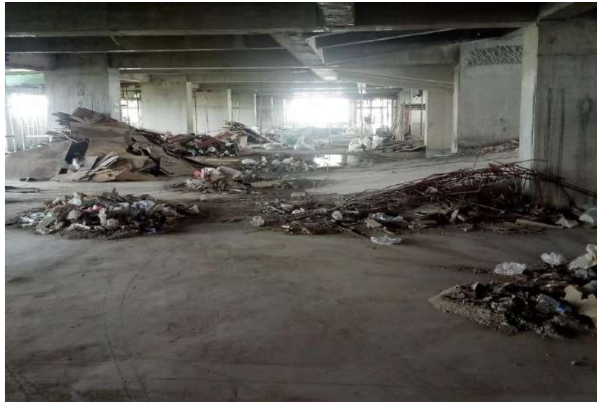
Gambar 4.6 Bekas bongkaran material tidak disingkirkan
