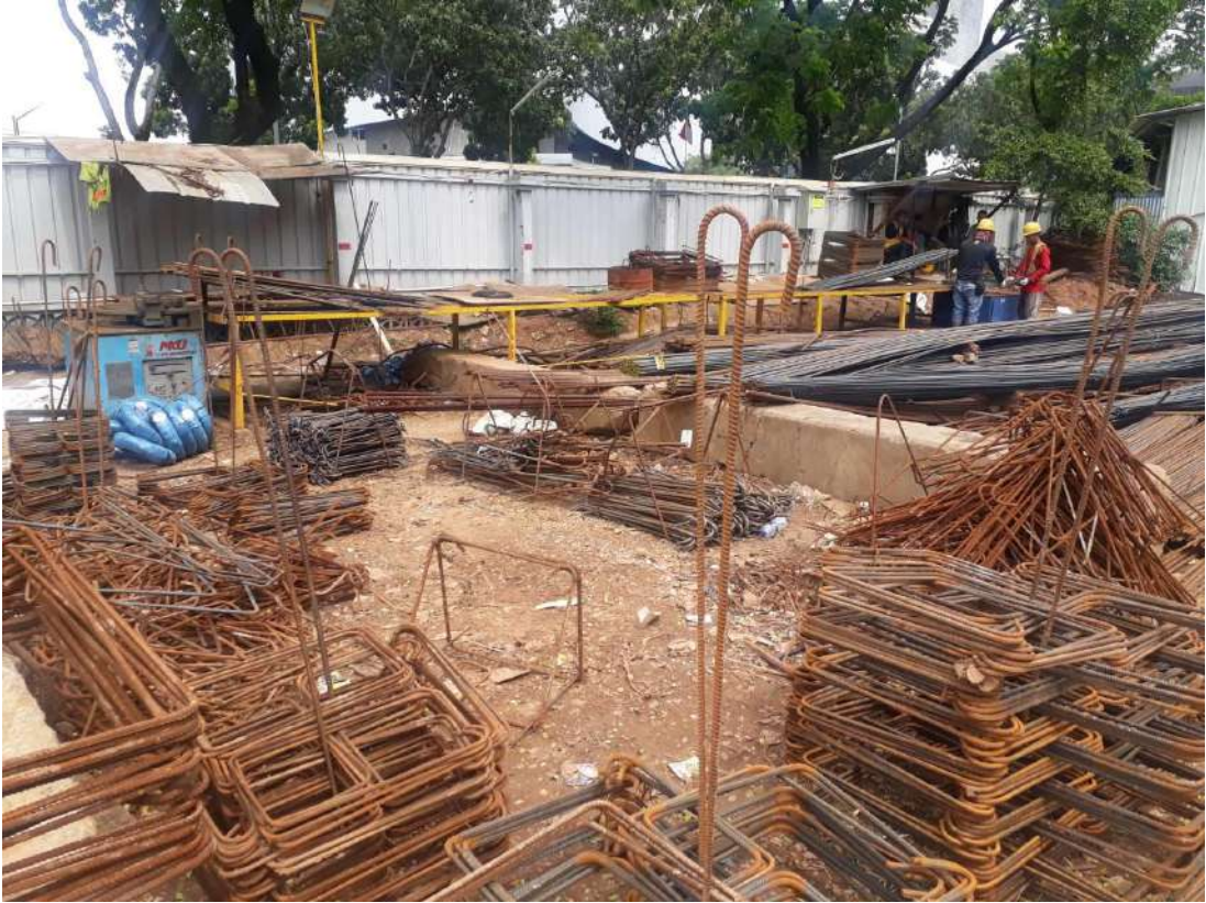
Gambar 4.8 Kegiatan Pembesian yang sudah rapi dengan meletakkan material sesuai dengan bentuk dan juga fungsinya.
