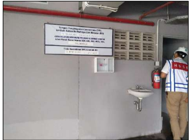
Gambar 8. Pengecekan Tempat Penyimpanan Sementara (TPS) Limbah B3
