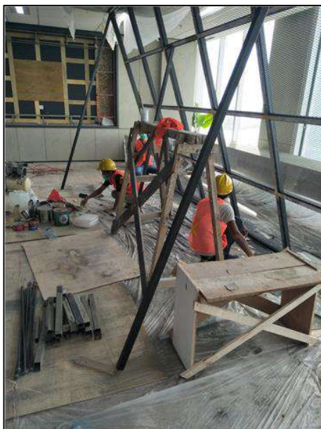
Gambar 11. Inspeksi Penggunaan APD Pada Pekerja
