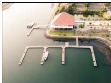
Gambar 4.4 Perbaikan Boom Marina Banyuwangi
