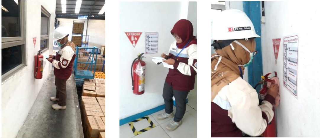
Lampiran 12.1 Melakukan Observasi Penerapan dan Pemeliharaan Alat Pemadam Api Ringan (APAR) Bulanan.
