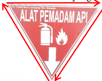
Lampiran 9.12 Lebar Segitiga Tanda Pemasangan APAR Kurang dari 35 cm, yaitu 24 cm Saja.
