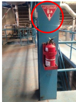
Lampiran 9.11 APAR yang Diletakkan Di Tiang Tidak Dilengkapi dengan Tanda Pemasangan APAR berupa Garis Merah Selebar 20 cm yang Melingkari Tiang.
