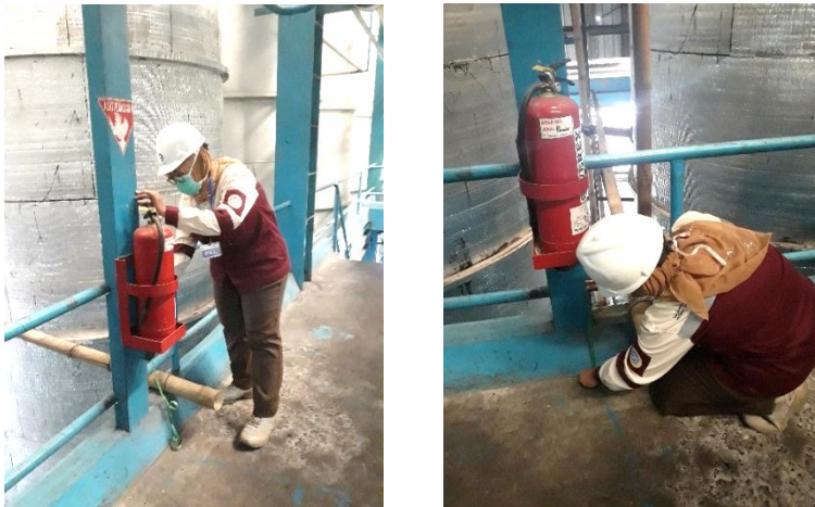
Lampiran 12.2 Melakukan Pengukuran Ketinggian Pemasangan APAR.
