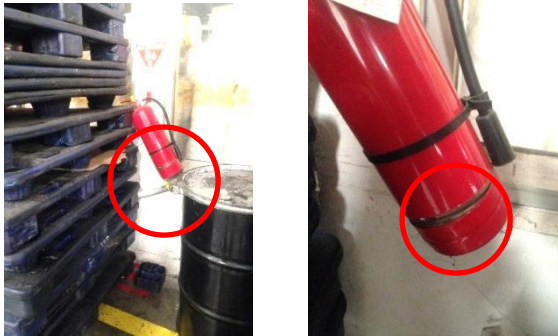
Lampiran 9.6 APAR yang Belum Memenuhi Standar Karena Penyok Terkena Hantaman Palet dari Forklift .
