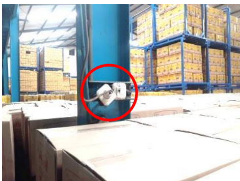
Lampiran 11.3 Stop Kontak yang Sudah Tidak Layak Pakai dapat Berpotensi Menyebabkan Korsleting hingga Kebakaran.
