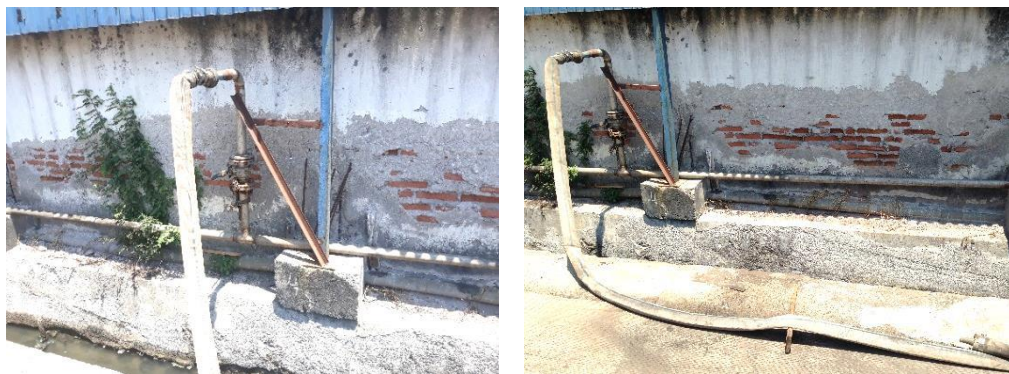
Lampiran 10.2 Jalur Air 1 untuk Proteksi Kebakaran.
