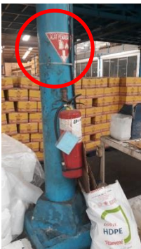
Lampiran 9.11 APAR yang Diletakkan Di Tiang Tidak Dilengkapi dengan Tanda Pemasangan APAR berupa Garis Merah Selebar 20 cm yang Melingkari Tiang.
