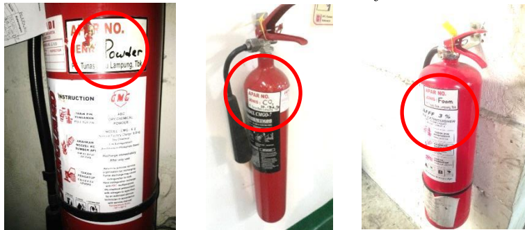
Lampiran 9.7 Tipe APAR Di PT. Tunas Baru Lampung, Tbk yang Terdiri dari Powder , CO 2 , dan Foam .
