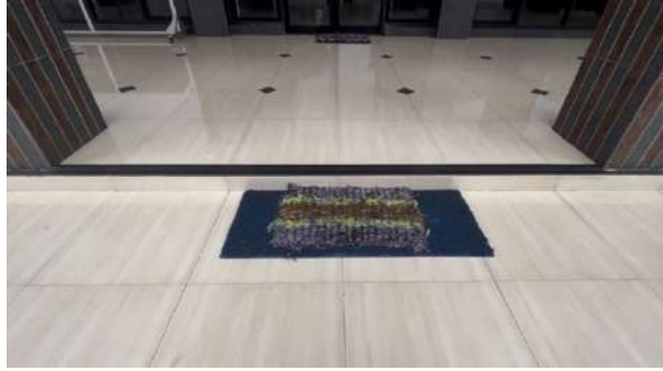
Gambar 4.9 Kondisi lantai Masjid Riyadhus Salma
