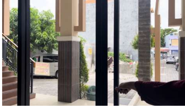
Gambar 4.11 Keberadaan ventilasi di Masjid Riyadhus Salma
