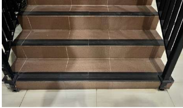
Gambar 4.19 Lebar tangga di Masjid Riyadhus Salma
