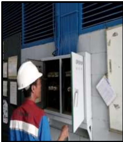
Gambar 3 : Mematikan sumber listrik
