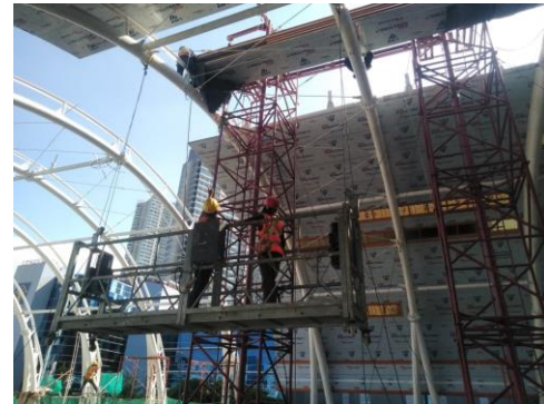
Pengamatan Pemasangan Sandwich panel Menggunakan Gondola
