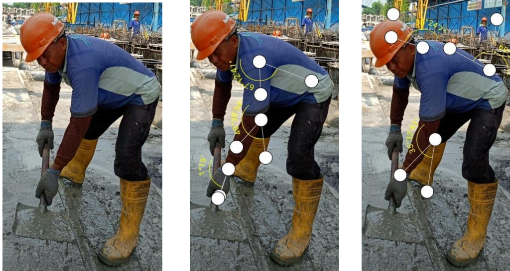
Gambar 4.2 Postur Kerja Aktivitas Pembersihan Adukan Pengecoran Beton
