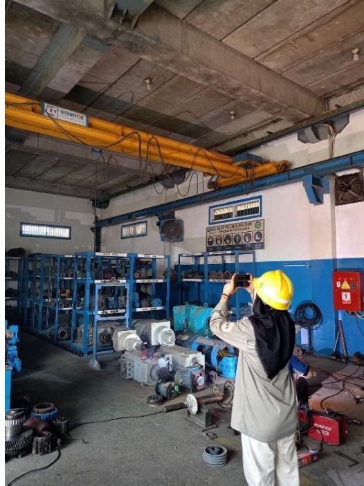
Gambar 4. 15 Tidak Adanya Tempelan pada Dinding yang Tidak Berkaitan dengan Kegiatan Workshop
