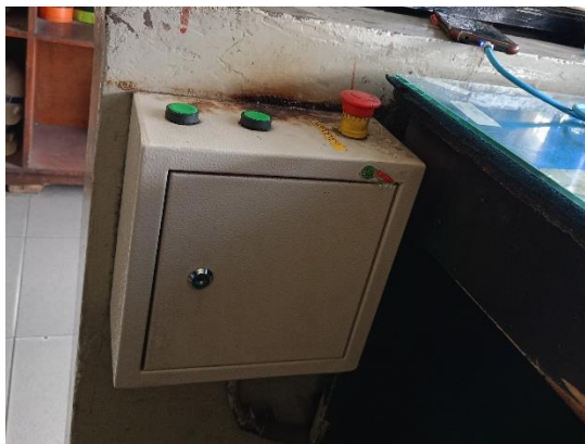
Gambar 4. 7 Alarm Kabakaran di PT Wijaya Karya Beton Tbk. Pasuruan
