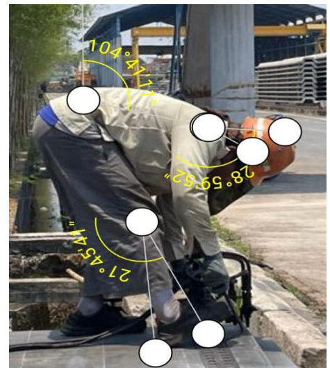
Gambar 4. 3 Proses Pemotongan Plat Sambung Tiang Pancang
