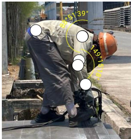
Gambar 4. 3 Proses Pemotongan Plat Sambung Tiang Pancang
