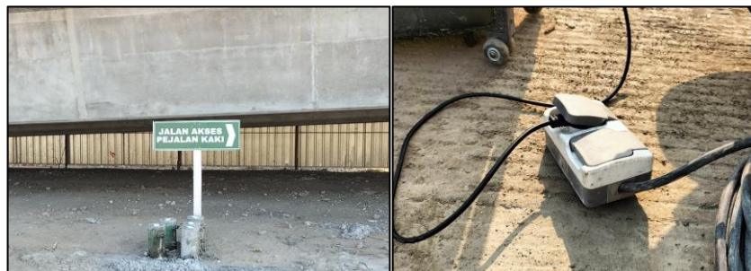
Gambar 4.7 Akses Pejalan Kaki dan Kabel Roll dengan Penutup
