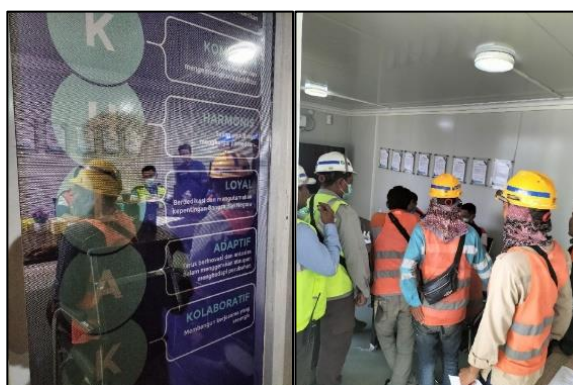
Gambar 4.12 Kegiatan daily check up sebelum pekerjaan major dimulai
