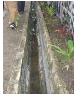
Terdapat saluran sudah permanen dengan kondisi baik dan kegiatan
