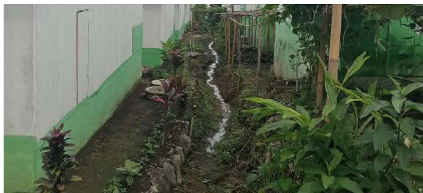
Gambar 4.6 Kondisi Selokan Belakang Rumah
