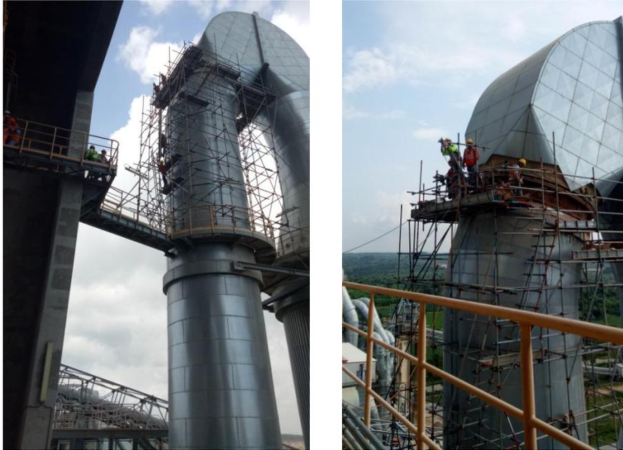
Gambar 4.1 Pekerjaan Perbaikan *Gas Conditioning Tower (GCT) Area Pre Heater Tuban 1*
