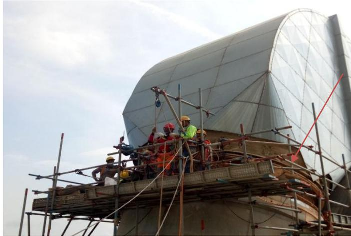
Gambar 4.5 Adanya sisi samping *scaffolding* yang belum tertutup *platform*
