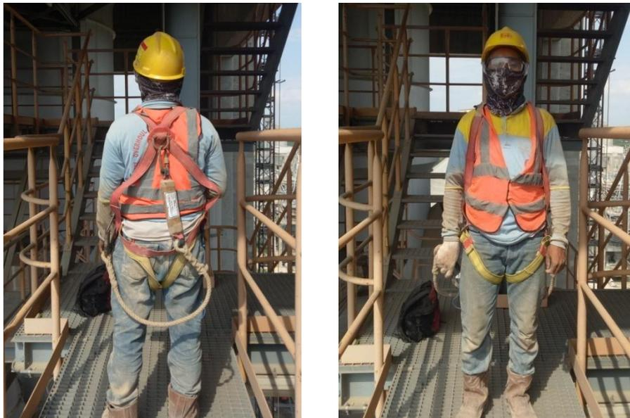
Gambar 4.7 Pekerja Menggunakan APD *Full Body Harness*
