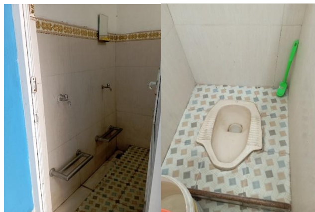
Gambar 4.12 Kondisi Toilet dan Tempat Wudhu
