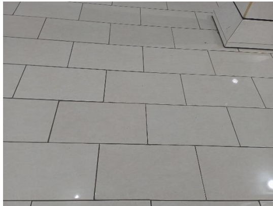
Gambar 4.7 Kondisi Lantai Masjid
