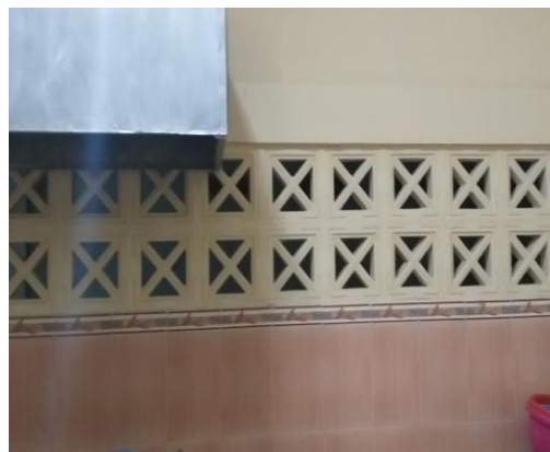
Gambar 4.6 Ventilasi di Ruangan Pengolahan Makanan
