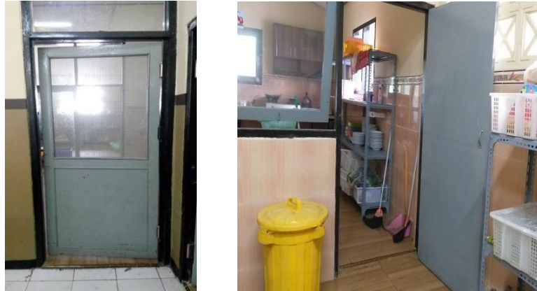
Gambar 4.4 Pintu dan Jendela dekat Ruang Pengolahan Makanan
