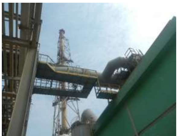
Cerobong asap di pabrik III Asam Sulfat
