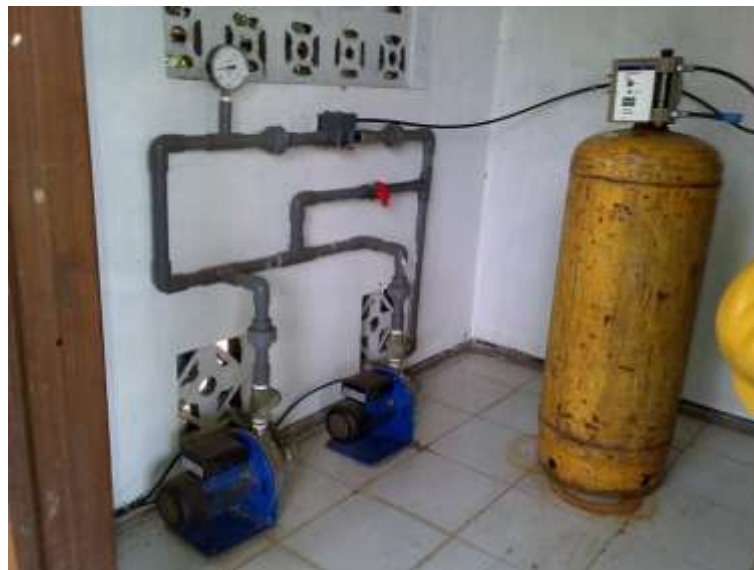
Gambar 4. 8 Instalasi Alat Chlorinasi
