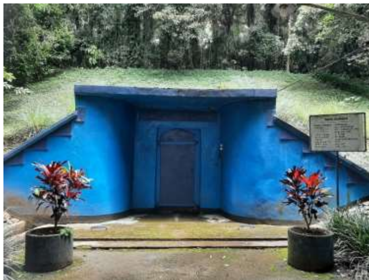
Gambar 4. 5 Bangunan Penangkap Air atau Broncaptering (BC)
