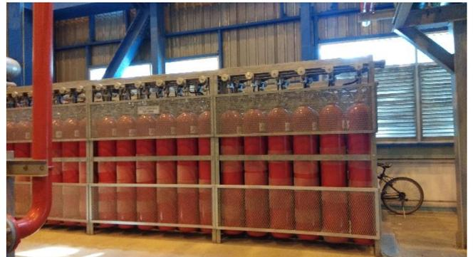
Gambar 13 Sistem CO<sub>2</sub> PT. Indonesia Power UPJP Perak-Grati
