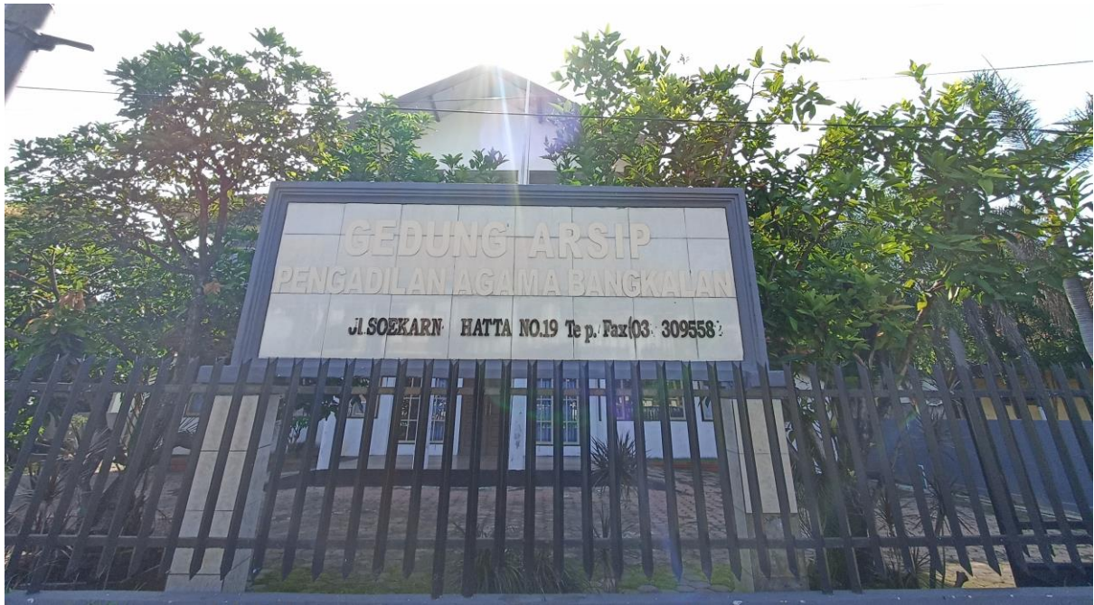
Lampiran 12. Gedung Arsip Pengadilan Agama Bangkalan
