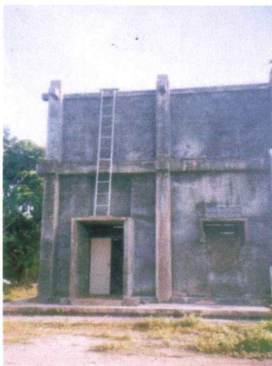
Gambar 3. Tower atau tandon utama
