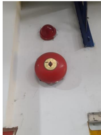
Gambar 4.18 Alarm Audible dan Visible
