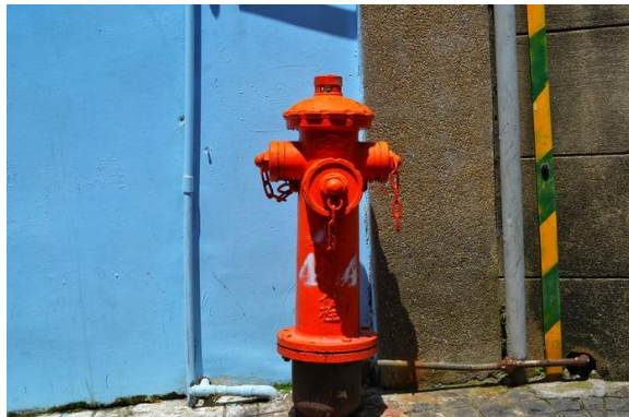
Gambar 2. 15 Hidran Halaman
