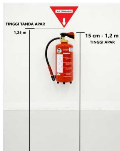
Gambar 2.13 Tinggi Pemasangan APAR
