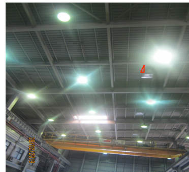
Gambar 4.13 Exhaust fan pada Area Workshop
