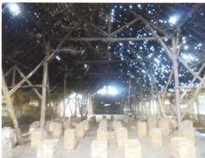
Gambar 4.13 Bagian dalam bangunan bekas gudang tembakau di Desa Talun, Bojonegoro
