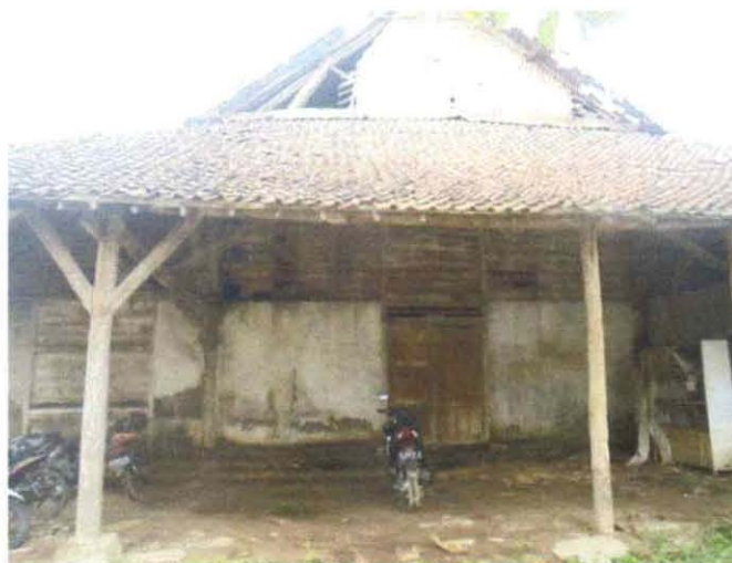
Gambar 4.12 Bangunan bekas gudang tembakau di Desa Talun, Bojonegoro tampak depan
