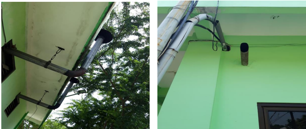
Gambar 4 4 Lubang Sampling Genset Pada Genset Perkin 1, Perkin 2 dan Genset MWM
