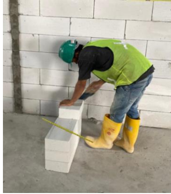
Gambar 2 Postur Tubuh Pekerja Finishing
