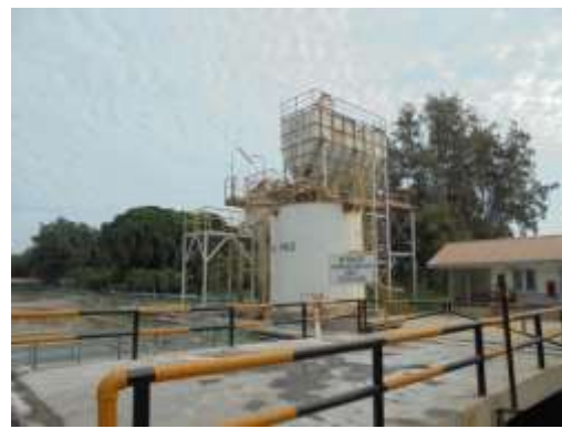
Gambar 10. Proses Injeksi Kapur
