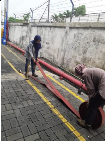
Melakukan pengecekan selang hydrant
