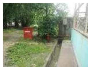
Gambar 4. 15 Hydrant di TPS 3
