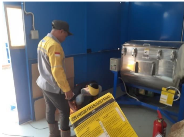
Gambar 4.36 Pengawasan Work Permit pada Pekerjaan Panas (Pengelasan)
