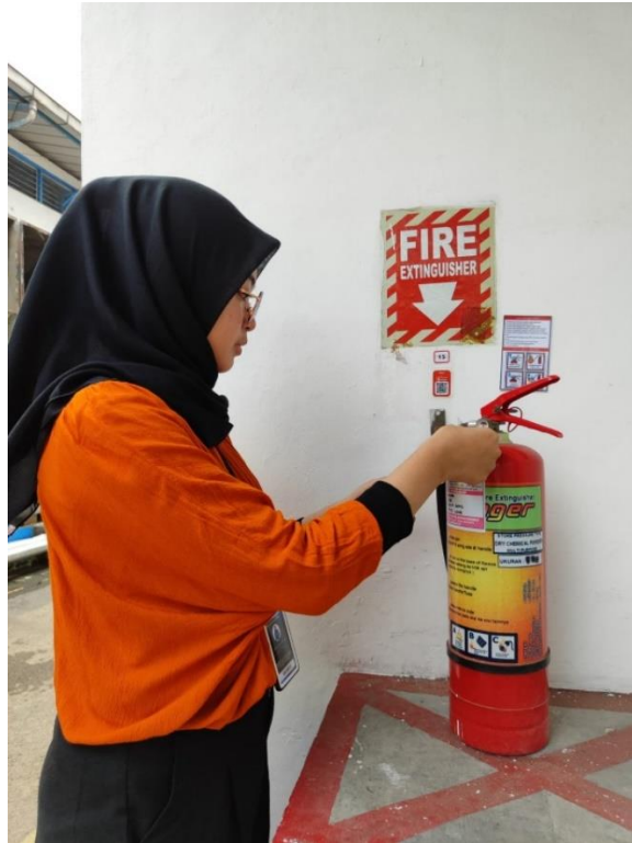
Gambar 4.47 Pengecekan Alat Pemadam Api Ringan (APAR)
