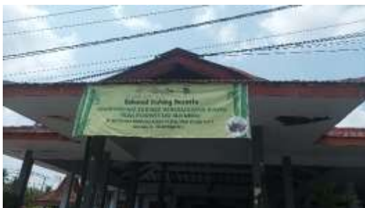
Survei lokasi rehabilitasi lahan Rusak di Kabupaten Malang
