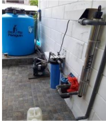
Gambar 4.30 Cartridge Filter dan Tandon Air di Catering Pawon Enggal Sekawan
