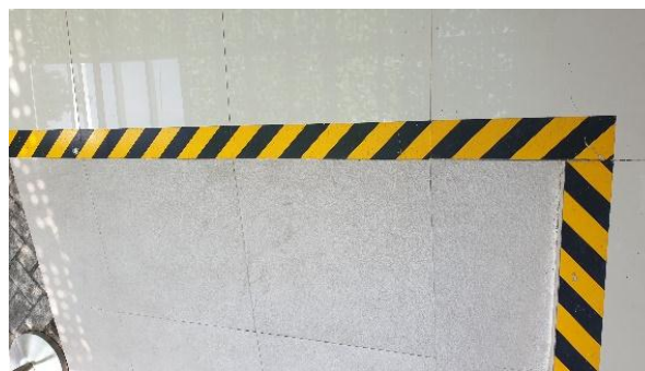
Gambar 4.44 Lantai dengan Perbedaan Ketinggian dan Penanda Garis Kuning Hitam di RSMM Jawa Timur
