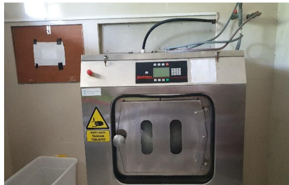
Gambar 4.5 Mesin Cuci Menggunakan Air Panas Untuk Linen Non Infeksius di Ruang Linen Bersih RSMM Jawa Timur
