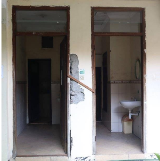
Gambar 4.14 Kondisi toilet pria dan wanita
